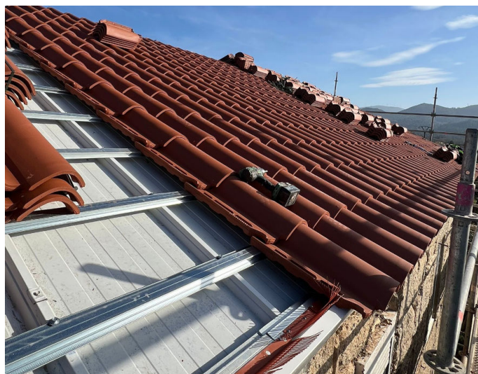
Panel aislante autoportante + rastrel + teja mixta Eterna
