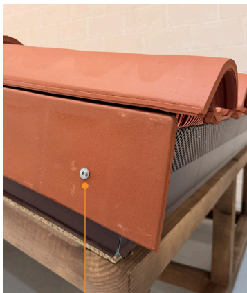
Fijación mecánica lateral del remate
