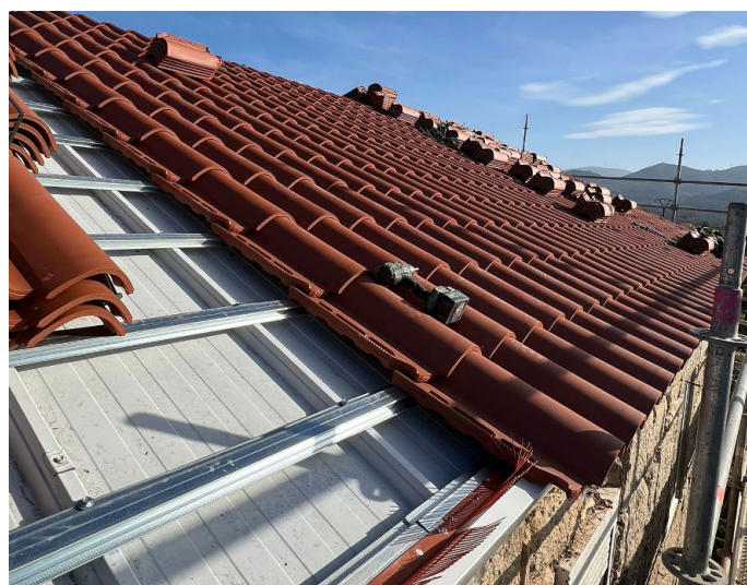
Panel aislante autoportante + rastrel + teja mixta Eternal
