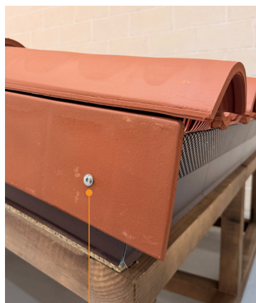
Fijación mecánica lateral del remate
