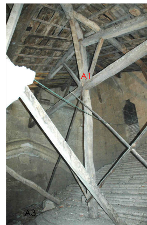
BAJO CUBIERTA ESTRUCTUA DENSA APOYADA EN BÓVEDAS PLANTA PRIMERA TABICADA - DEMOLICIÓN ESPACIO DIÁFANO BÓVEDAS CUBIERTAS ECHADIZOS Y RELLENOS
